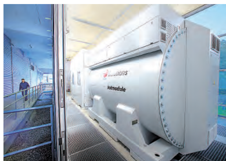
T-Systems nutzt erstmals weltweit eine Biogas-Brennstoffzelle im Dauerbetrieb für ein Rechenzentrum. Foto: T-Systems
